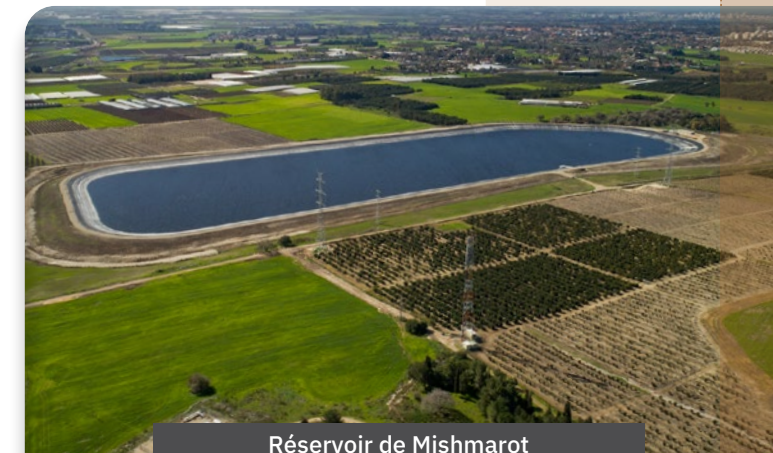
Réservoir de Mishmarot Photo: Eyal BarTov, 2020, Archive du KKL-JNF
